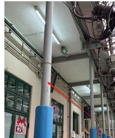
PT-06 塗料和原有牆身塗料匹配 (柱子)
